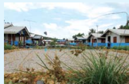
Sub-terra reed bed
